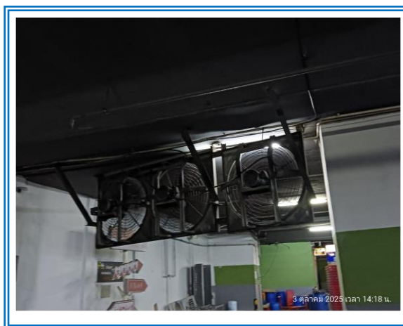
รูปที่ 3-10 เครื่องระบายอากาศในพื้นที่จอดรถ
