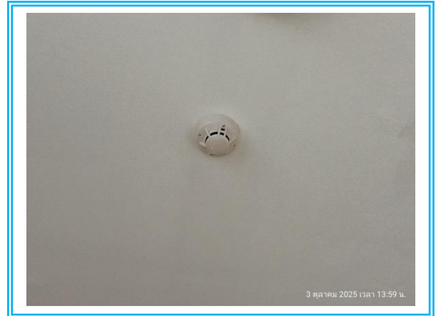
รูปที่ 2.11-2 เครื่องตรวจจับควันและความร้อน Tower C2
